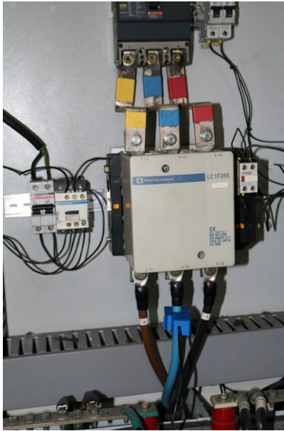
Figura 4. Instalación del sensor de corriente para la medición del consumo y comportamiento de la red eléctrica del equipo.
